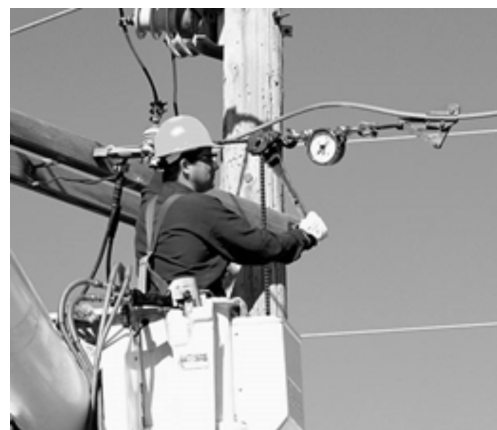
Hình PL5.5. Hình ảnh đo cáp tại hiện trường
